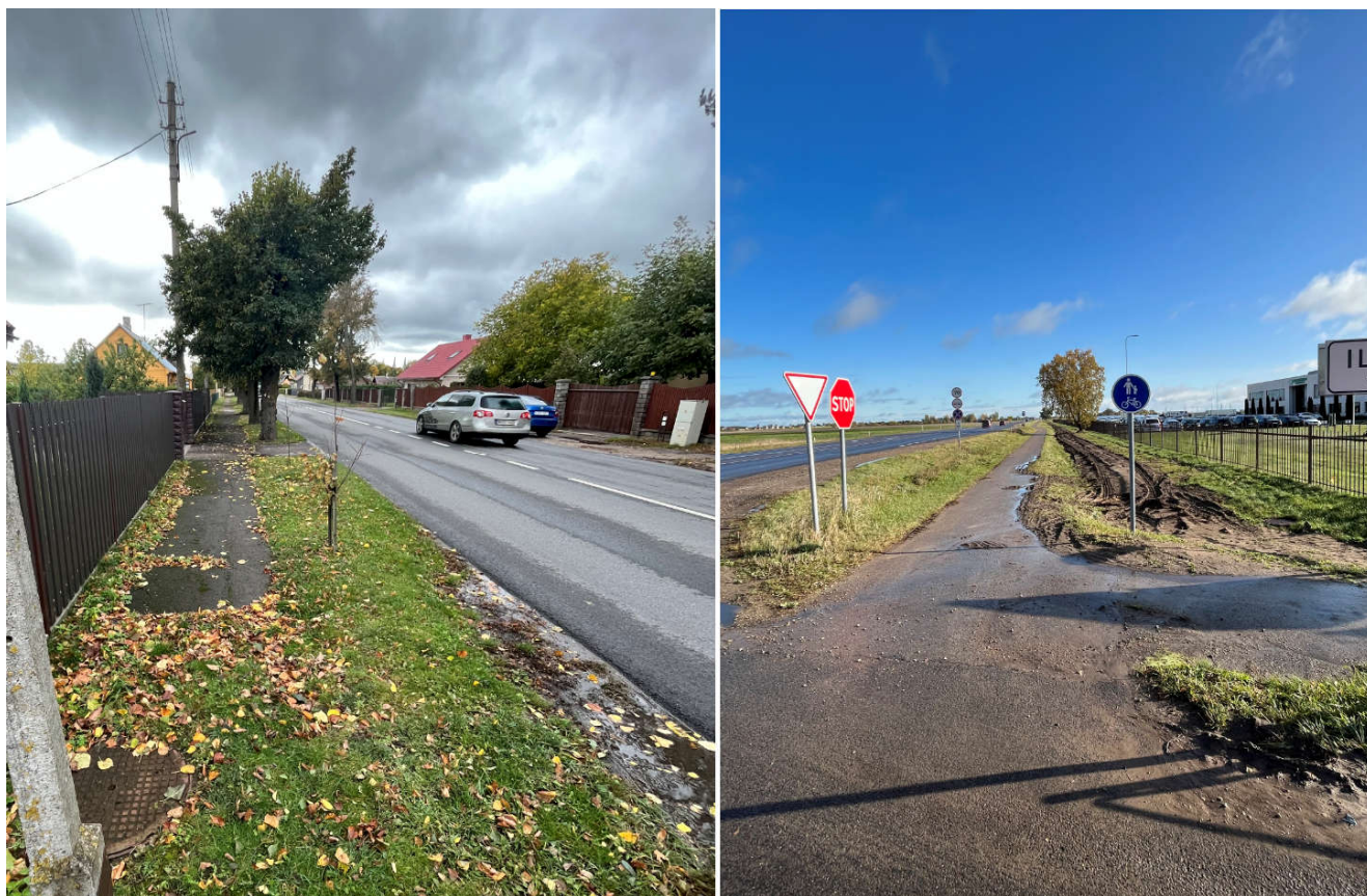
2 pav. Esamos takų infrastruktūros ties remontuojamo kelio ruožo pradžia ir pabaiga
